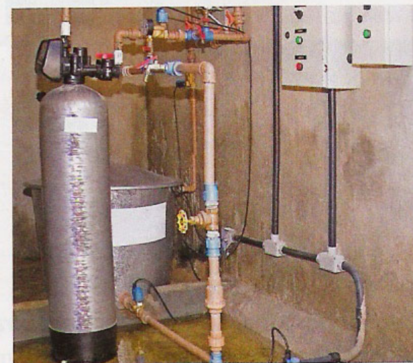
Figura 1 – Central de tratamento de sistema de aproveitamento de água de chuva em implantação: (a) Filtro de areia; (b) Central de tratamento
