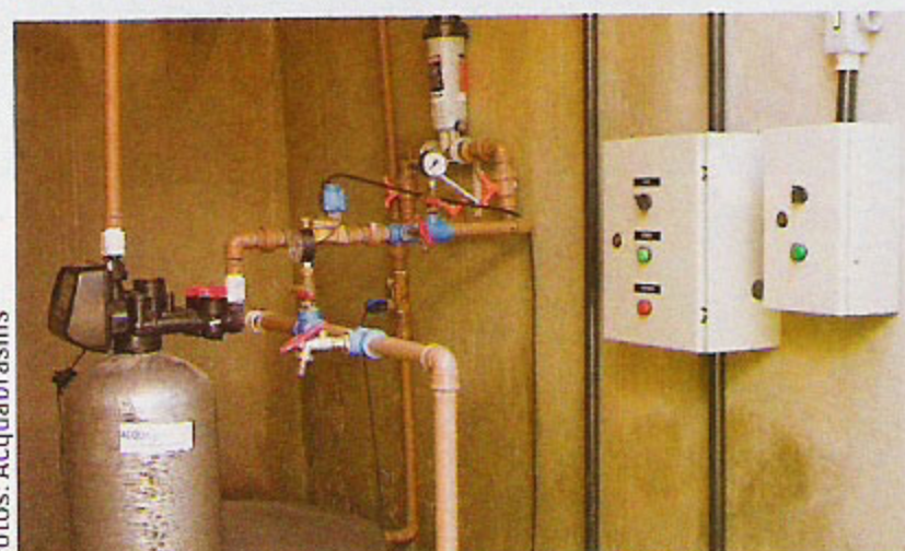
Figura 3 – Componentes da central de tratamento de sistema de aproveitamento de água de chuva em implantação: (a) Sistema de desinfecção de linha; (b) Válvula automática para filtro; (c) Vista geral dos componentes de automação do sistema; (d) Quadro elétrico de comando
