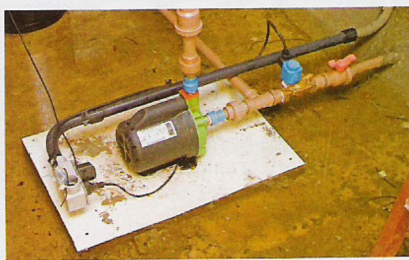
Figura 2 – Componentes da central de tratamento de sistema de aproveitamento de água de chuva em implantação: (a) Bomba centrífuga; (b) Reservatório de autolimpeza
