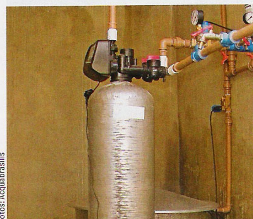
Figura 1 – Central de tratamento de sistema de aproveitamento de água de chuva em implantação: (a) Filtro de areia; (b) Central de tratamento
